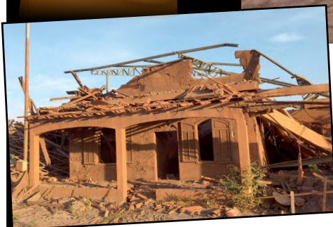
Casa destruída pela lama da barragem em Bento Rodrigues
